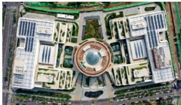
这是位于雄安新区启动区内的中国电信智慧城市产业园（8月8日摄，无人机照片）。新华社记者王晓 摄
