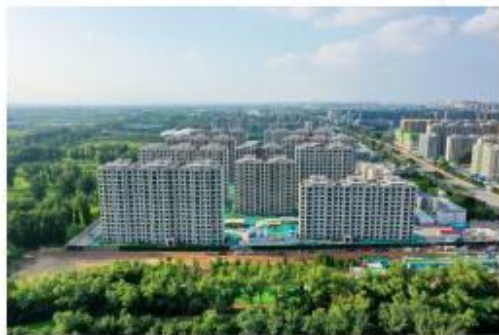
大兴新城西片区南区28地块项目
