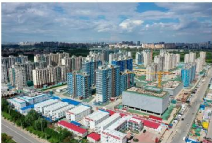
大兴新城西片区北区06/09/10地块项目
