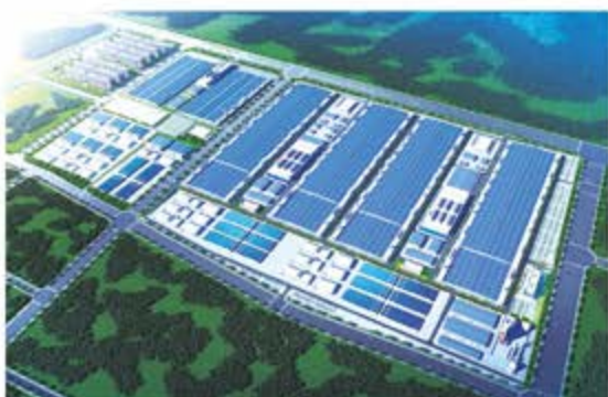
泾河新城光伏能源产业
