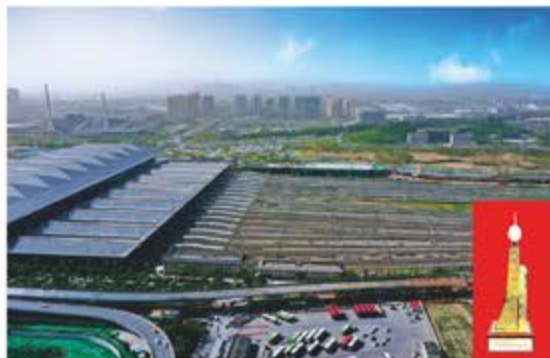
西安北客站枢纽工程
