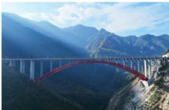
重庆东溪河特大桥
