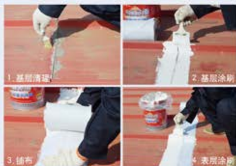
金属屋面搭接处施工流程
