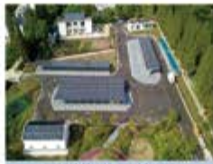
BIPV光伏车棚项目
