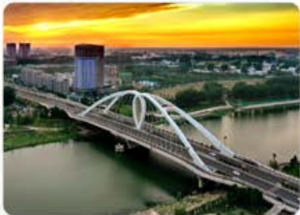
漯河市牡丹江大桥
