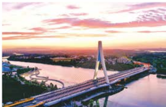
石家庄学府路东延跨太平河钢箱梁工程
