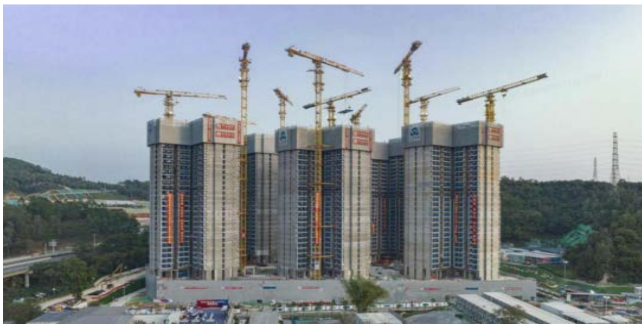
龙华樟坑径保障房项目
