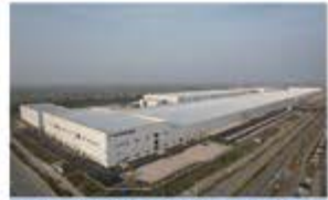
蜂巢创业空间科技产业园外围护工程
