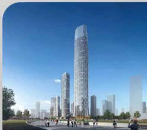
日照海韵广场智慧物茂综合体项目
