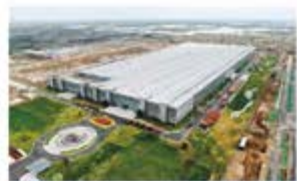
西安三一智能制造装备产业园项目
