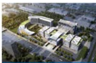
北京口腔医院迁建工程
