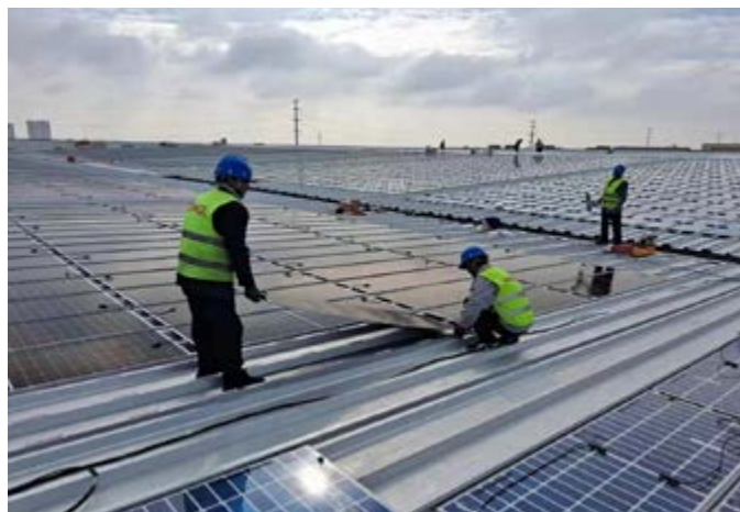
光伏屋面板施工现场
