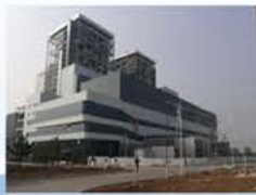
神华富平2*660MW电厂降噪治理项目
