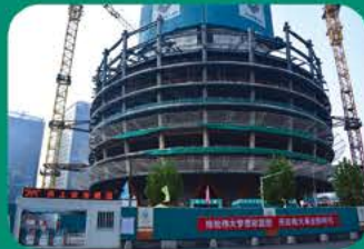
北京城奥大厦（北京朝阳）
