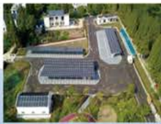
BIPV光伏车棚项目
