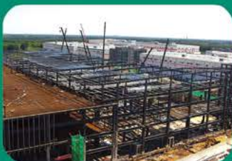
京东马驹桥物流园（北京通州）
