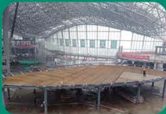
北京大兴国际机场（北京大兴）
