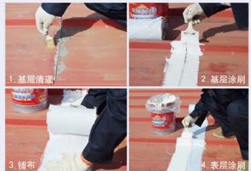
金属屋面搭接处施工流程
