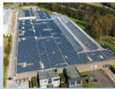
中煤大海则屋面光伏项目
