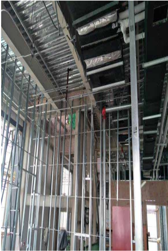
轻钢龙骨施工
