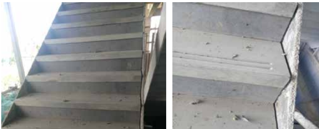
钢楼梯及上面安装的预制踏步板
