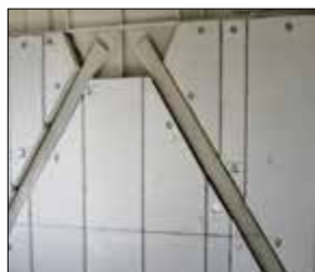
斜撑处墙板节点
