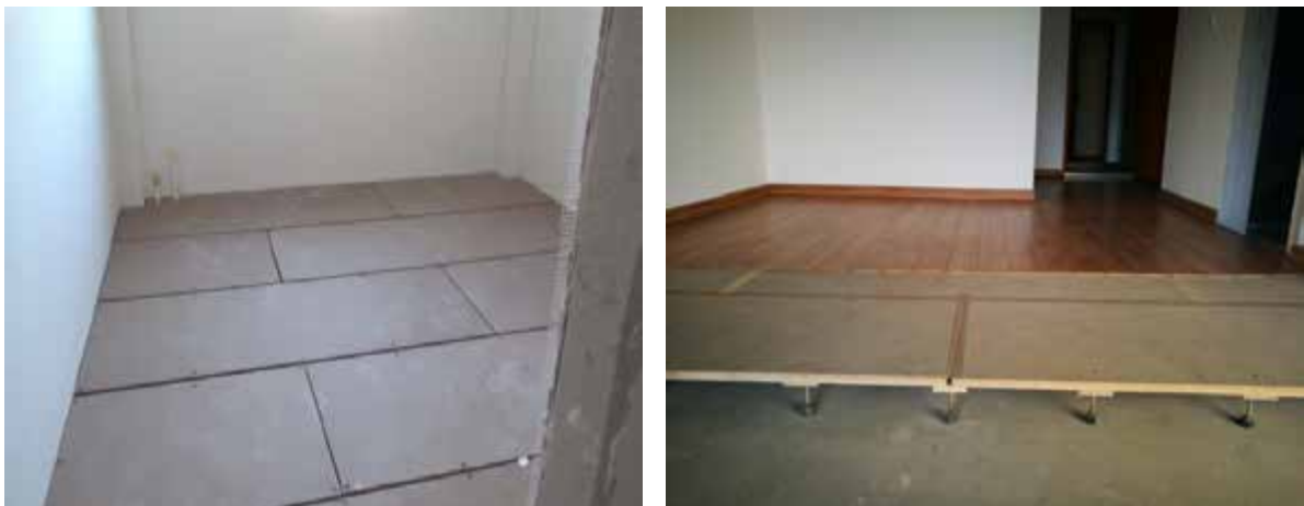
图 5.6-5 基层板及木地板铺设
