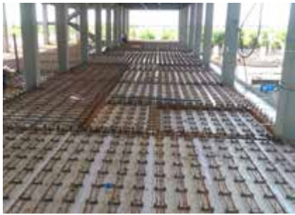
可拆底模式钢筋桁架楼承板铺设
