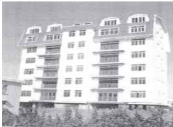
图 1-5 北蔡 8 层钢结构住宅楼
