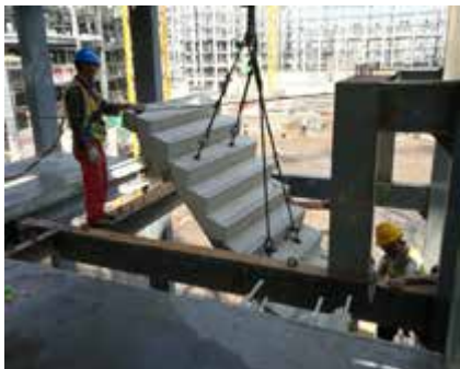
预制装配式钢筋混凝土板式楼梯吊装
