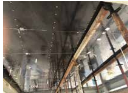
可拆底模式钢筋桁架楼承板支撑
