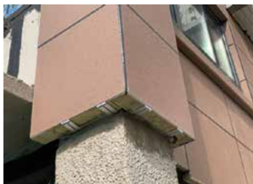
外墙保温采用保温装饰一体板
