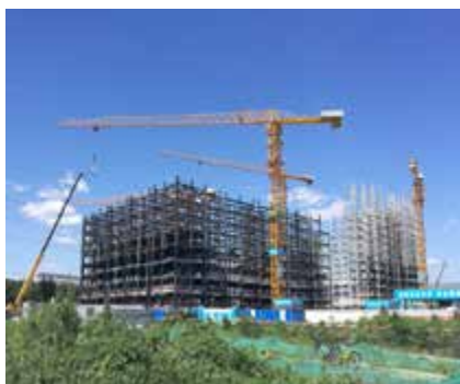
过程整体施工照片 1
