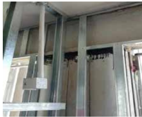
垂直电管走在石膏板隔墙的轻钢龙骨之间
