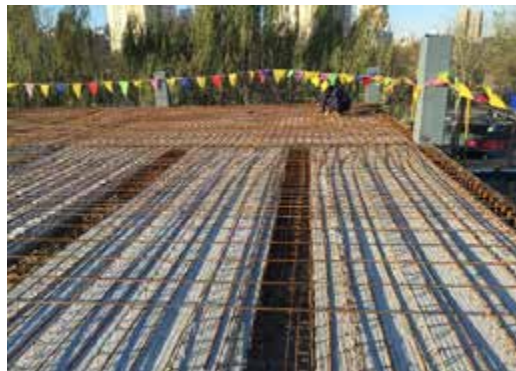
钢筋桁架楼承板底部安装示意
