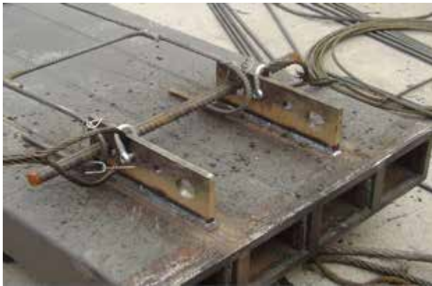
(图1) 钢管束吊耳板示意图
