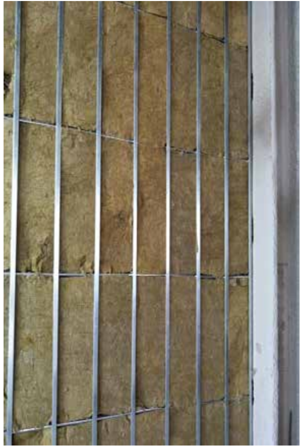
龙骨间填塞岩棉板
