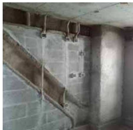
钢支撑位置的隔墙采用加气混凝土砌块
