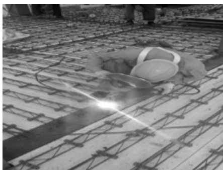
支座筋的焊接
