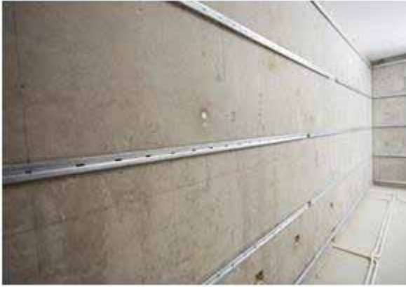
装配式干挂墙面图示
