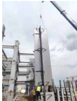
(图2) 钢管束现场吊装
