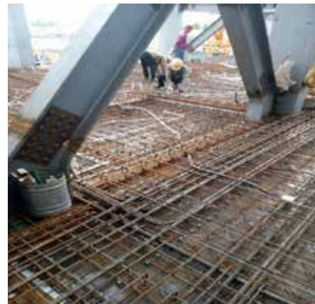
钢筋桁架楼承板
