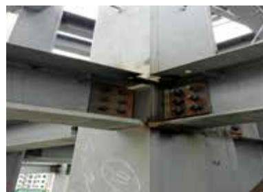
钢梁与钢柱的连接
