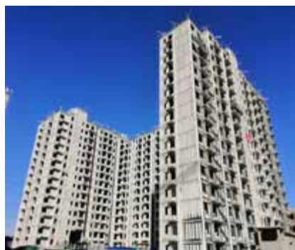
过程整体施工照片 2
