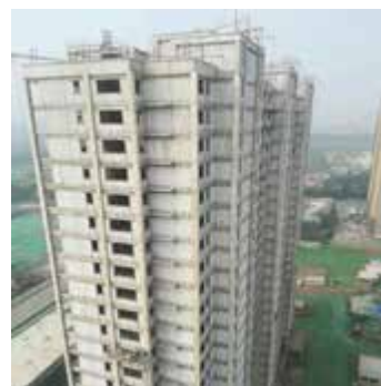
外围护墙板安装完成
