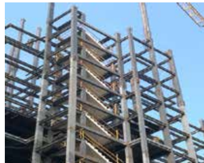
预制装配式钢筋混凝土板式楼梯安
