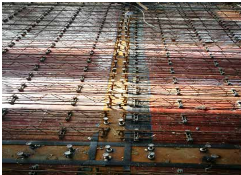
硬质塑料条封堵梁边板缝
