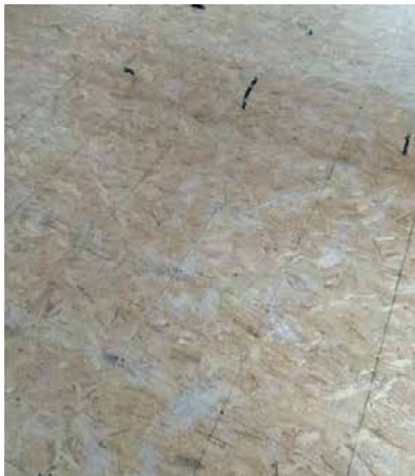
铺设 OSB 地板
