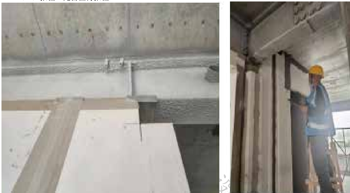
(a) 安装U型卡； (b) 贴纤维网格布
