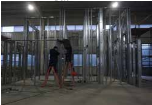
图 5-11 墙片校正
