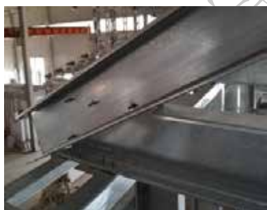
图 5-43 桁架与墙体连接
