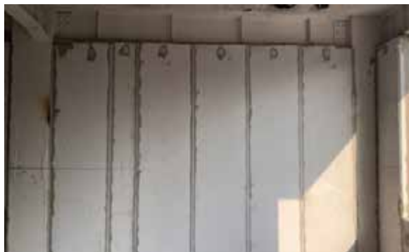
图 4-22 钩头螺栓连接
