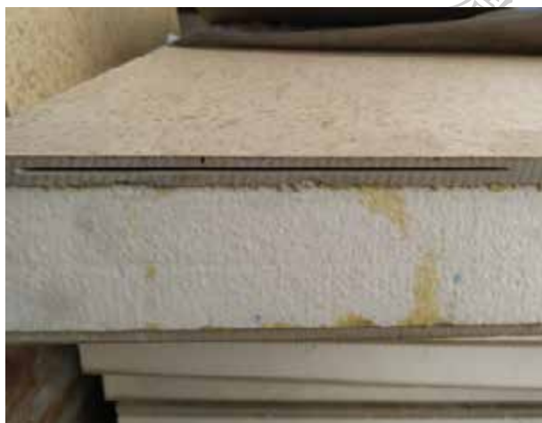
图 5-29 安装槽切割
