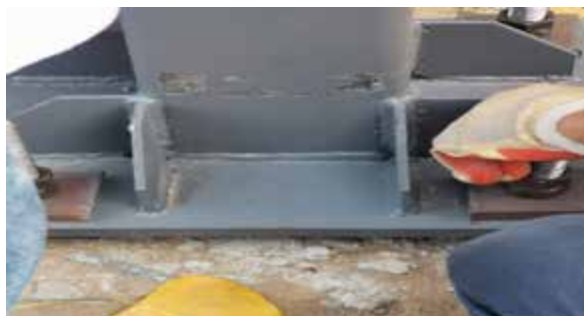
图 5-4 螺栓紧固
