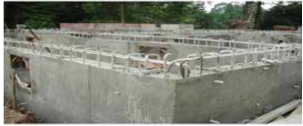
图2 筏板基础设置风口
