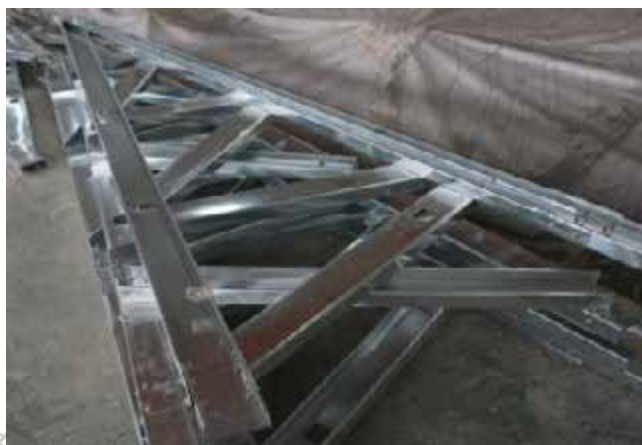
图 5-42 单榀桁架组装
