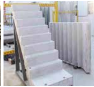
5.4 预制楼梯安装
