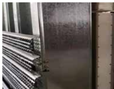
图 5-36 外墙内侧高肋钢板网
