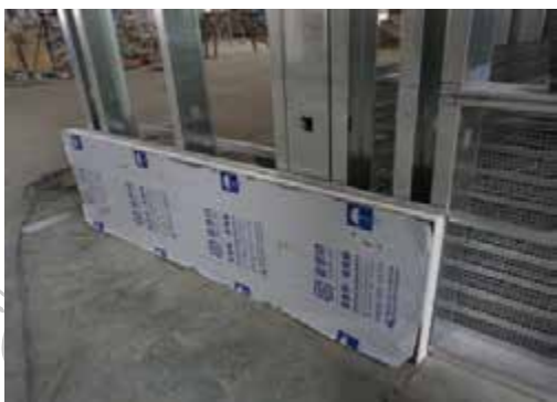
图 5-30 第一块板安装
