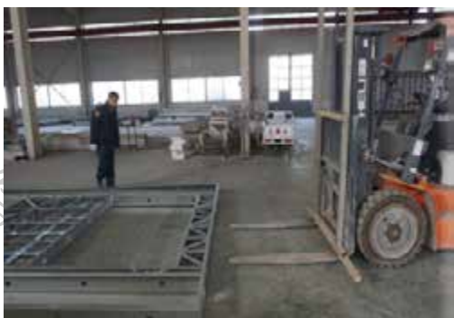
图 5-9 墙片吊装准备
