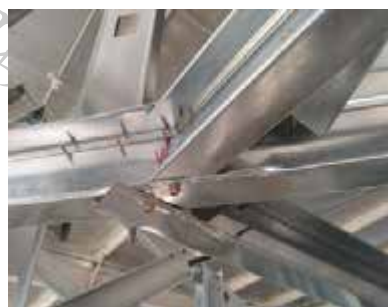
图 5-44 桁架之间连接
