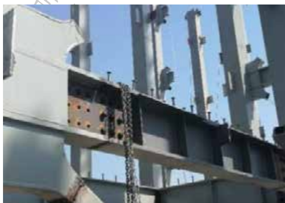
图 (a) 螺栓穿孔；(b) 螺栓紧固
