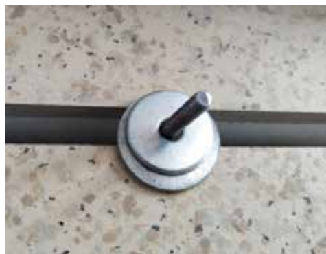
图 4-27 两侧外模板设对拉杆
