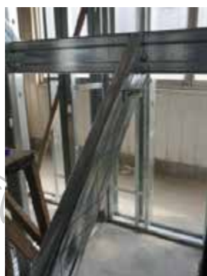
图 5-24 楼梯板梁安装
