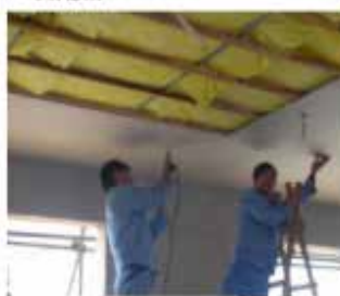
3.室内预制楼层安装
