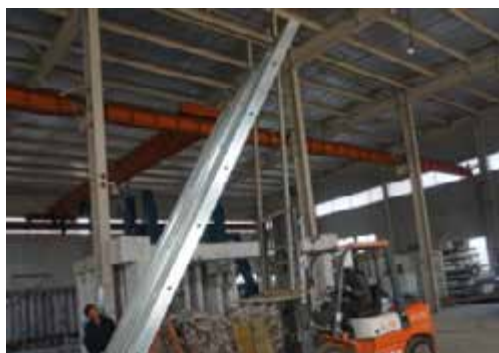
图 5-10 墙片吊装
