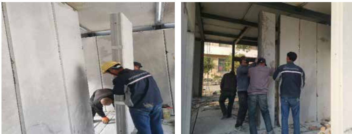
图 5-7 内墙墙板安装
