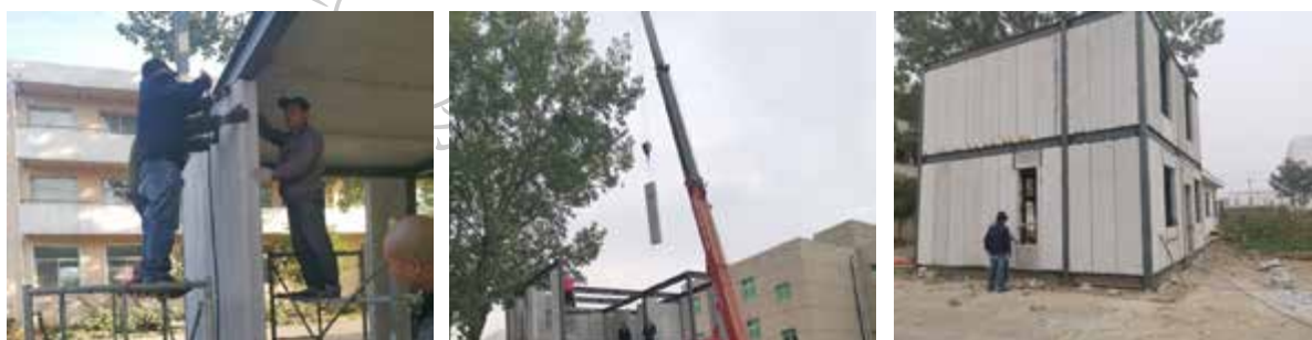
图 5-5 墙板安装
