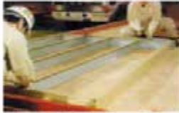
2. 墙体、窗洞、门洞工厂预制
