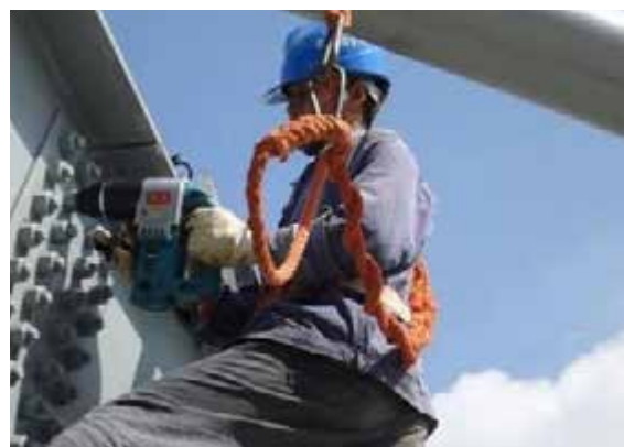
图 (a) 螺栓穿孔；(b) 螺栓紧固
