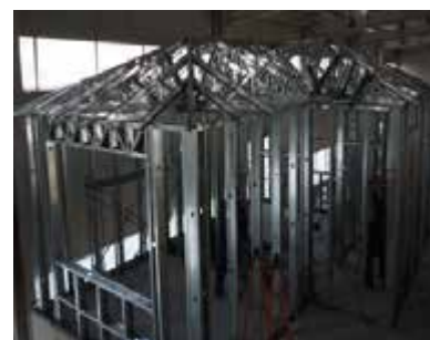
图 5-45 屋架安装完成
