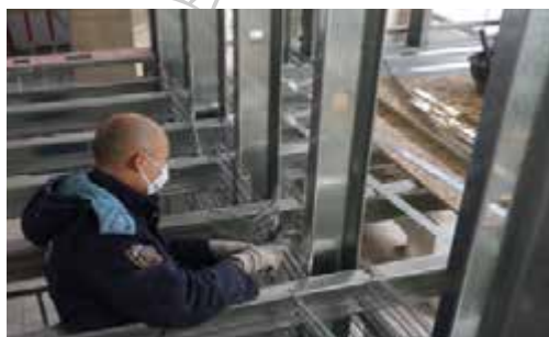
图 5-40 轻钢立柱间安装钢板网
