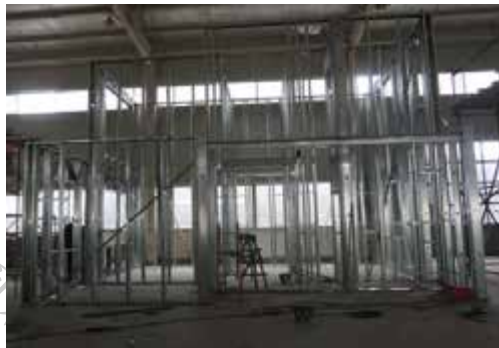
图 5-12 斜撑加固
