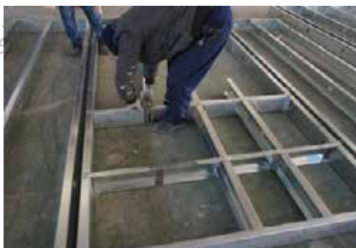
图 5-8 连梁安装
