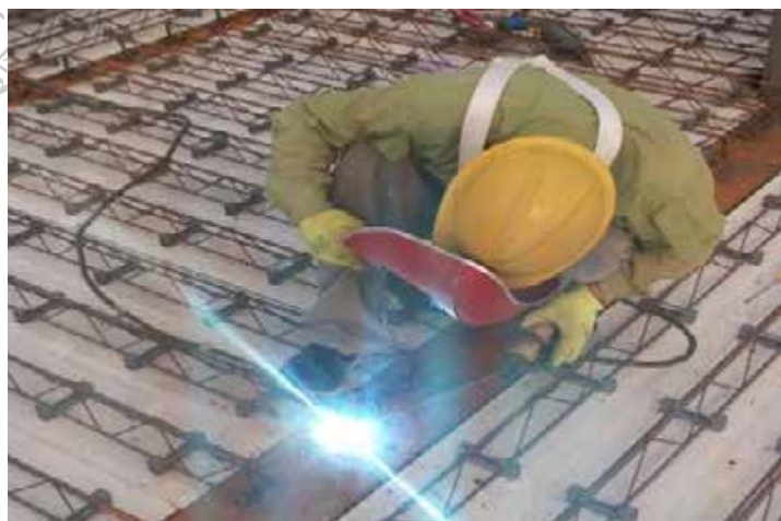
支座筋的焊接
