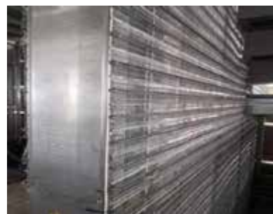
图 5-37 内墙两侧低肋钢板网
