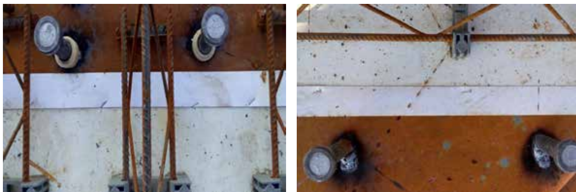
硬质塑料条封堵梁边板缝
