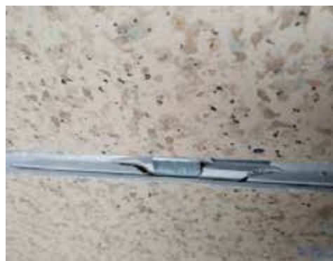
图 4-23 侧缝拉裂
