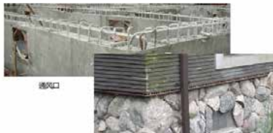
轻钢房屋的双层空气层构造体系
