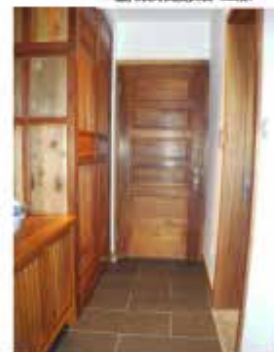
6.室内装饰安装(走廊)
