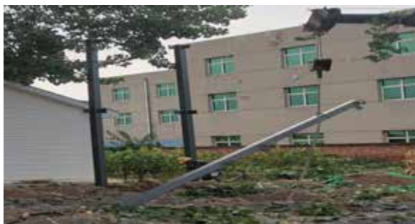
图 5-3 钢柱吊装
