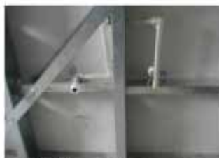
1.给排水管安装
