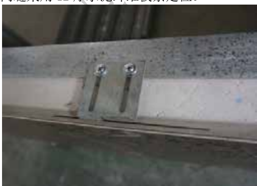
图 5-32 安装拉件
