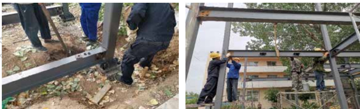
图 5-3 钢梁吊装，螺栓紧固
