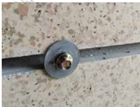
图 4-26 横向龙骨打外拉钉
