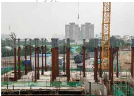
(b) 钢柱吊装
