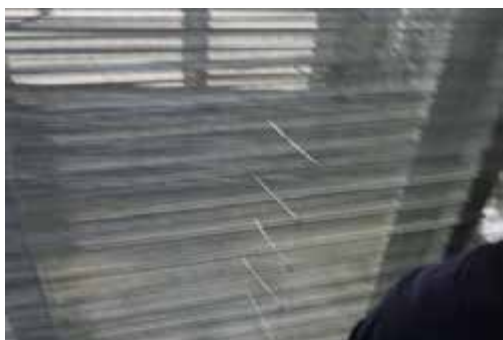
图 3-38 内墙钢板网对拉件
