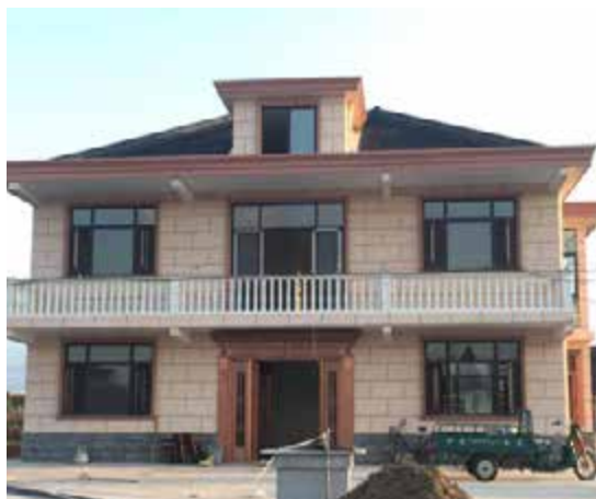
南通市轻钢结构装配式农房
