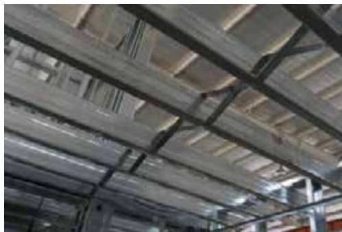
图 5-20 梁支撑安装
