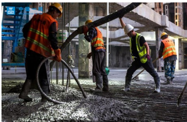
项目底板浇筑施工现场
