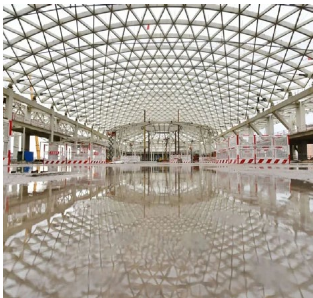
国家会议中心二期（索拱屋盖建造）©北京建工
