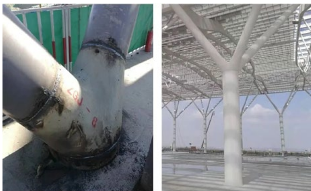
图 12 树形柱及 V 形柱分叉节点实景图
