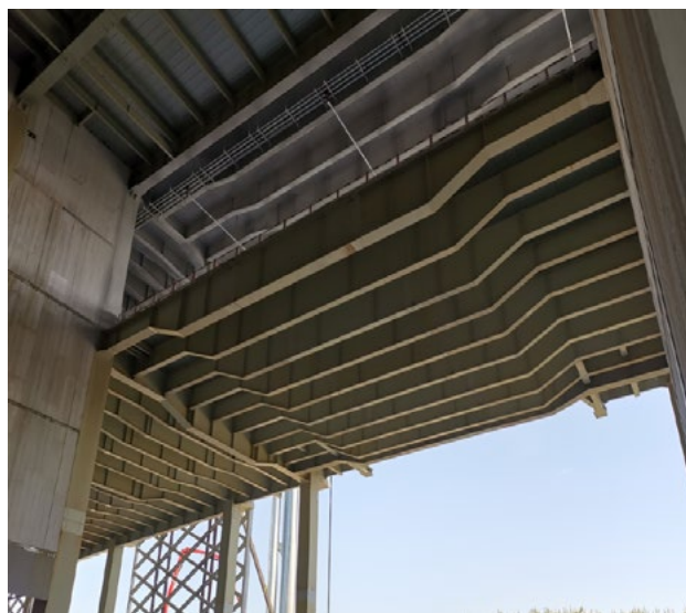
国家会议中心二期（钢结构建造）
