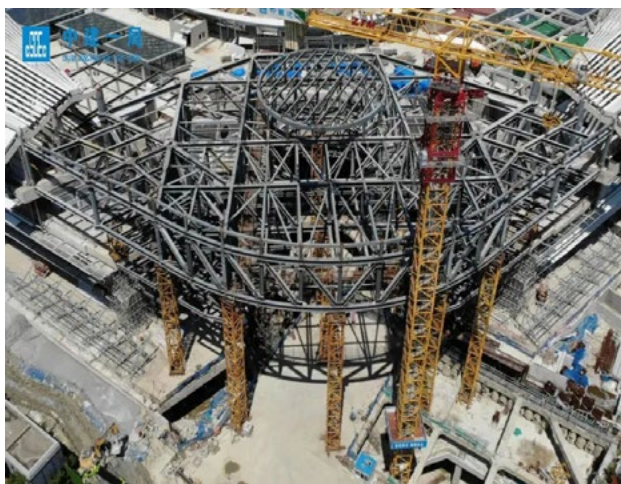
项目钢结构实景图
